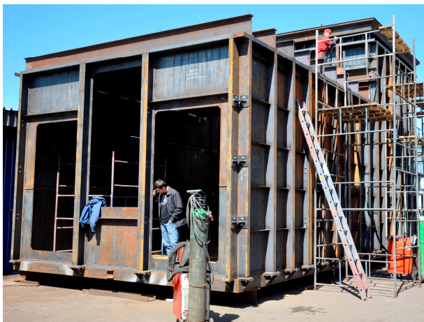
Komora spalania – etap prefabrykacji
